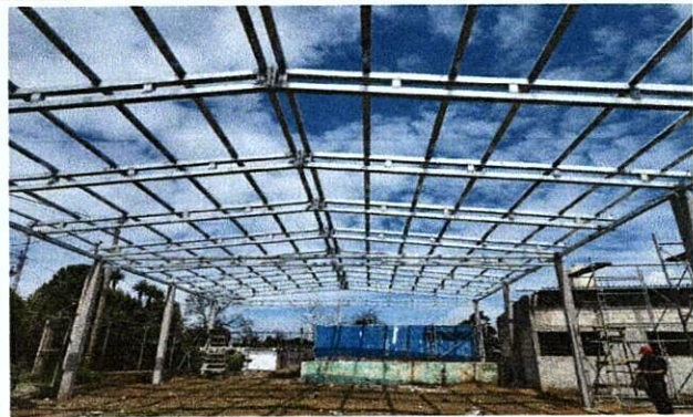
Foto 2: Estructura de techo para el mejoramiento del salon de usos multiples del Centro Educativo
